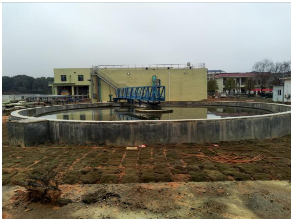
二期工程沉淀池
