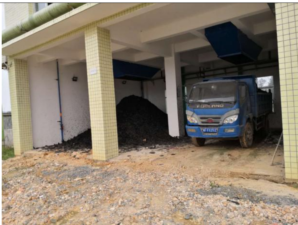
一期工程污泥脱水间
