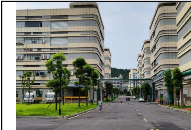
工程师现场踏勘照片 1
