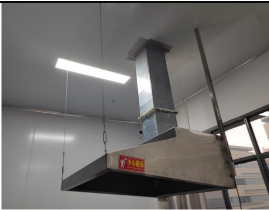
车间内集气现状
