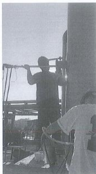
Y2:氰化尾矿因科法脱氧反应槽尾气排气筒出口
