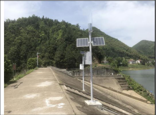
观测设施不足
