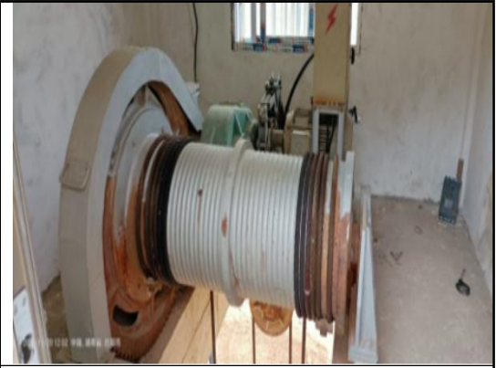
启闭机锈蚀
