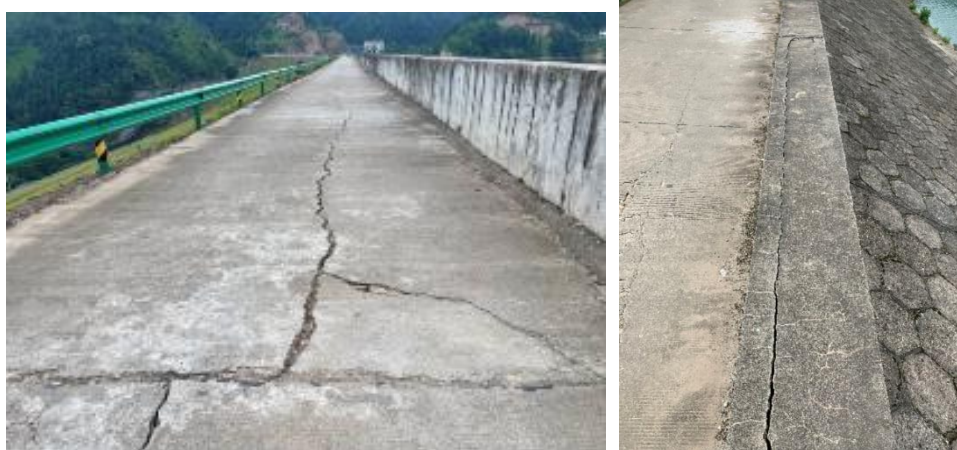
图 3.1 坝顶路面及防浪墙现场照片
