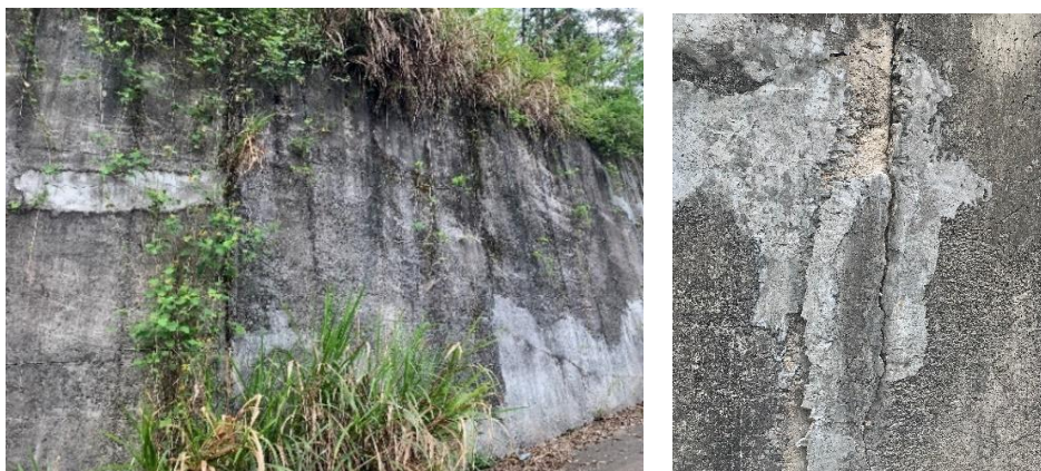
图 3.3 溢洪道侧墙现场照片
