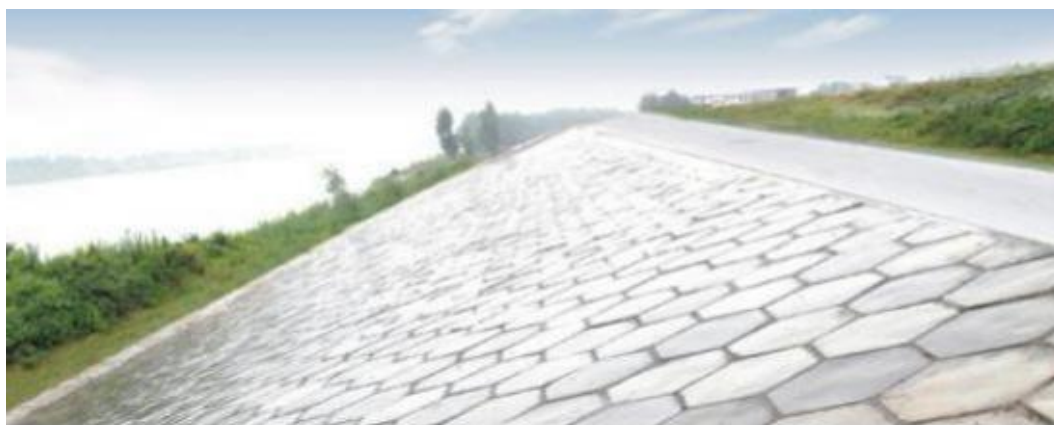
图 2.2 预制砼六方块护坡示意图
