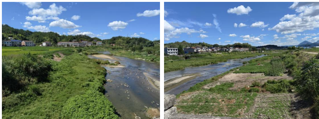
图 3.2 河道淤积照片（图左为高坪村附近，图右为南江镇镇区附近）
